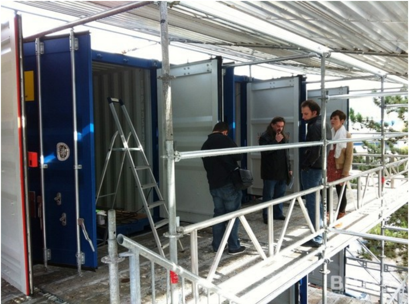
Installation des containers de visarte.jura
